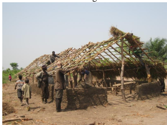
De kinderen helpen bij het gras snijden en dragen, de mannen bedekken het dak ermee.
